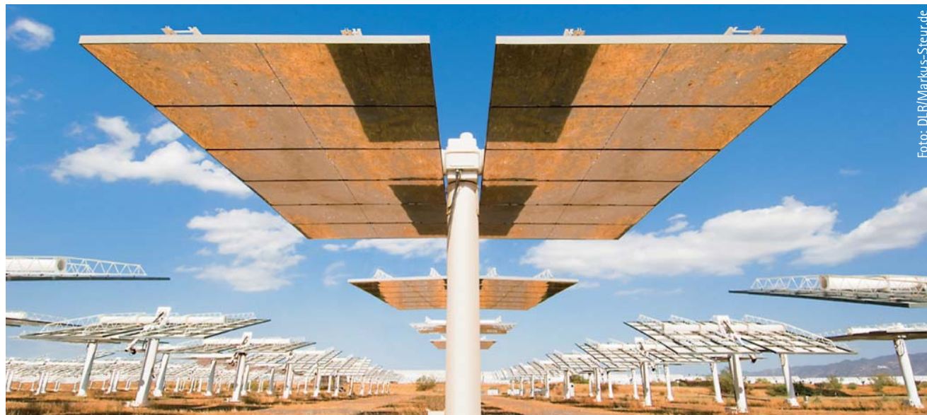
Kollektoren eines Sonnenwärme-Versuchskraftwerks nahe Almería in Spanien.
